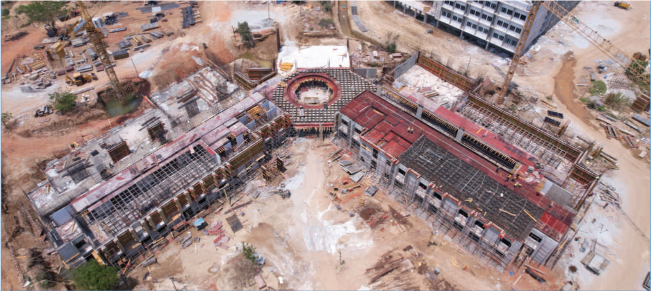
व्याख्यान हॉल कॉम्प्लेक्स निर्माण
