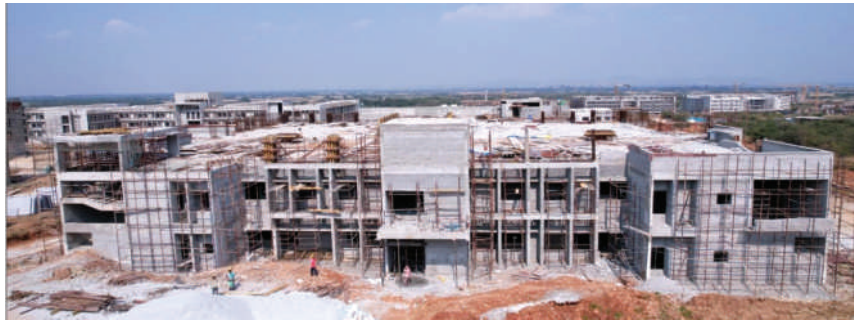
भोजन गृह ब्लॉक निर्माण
