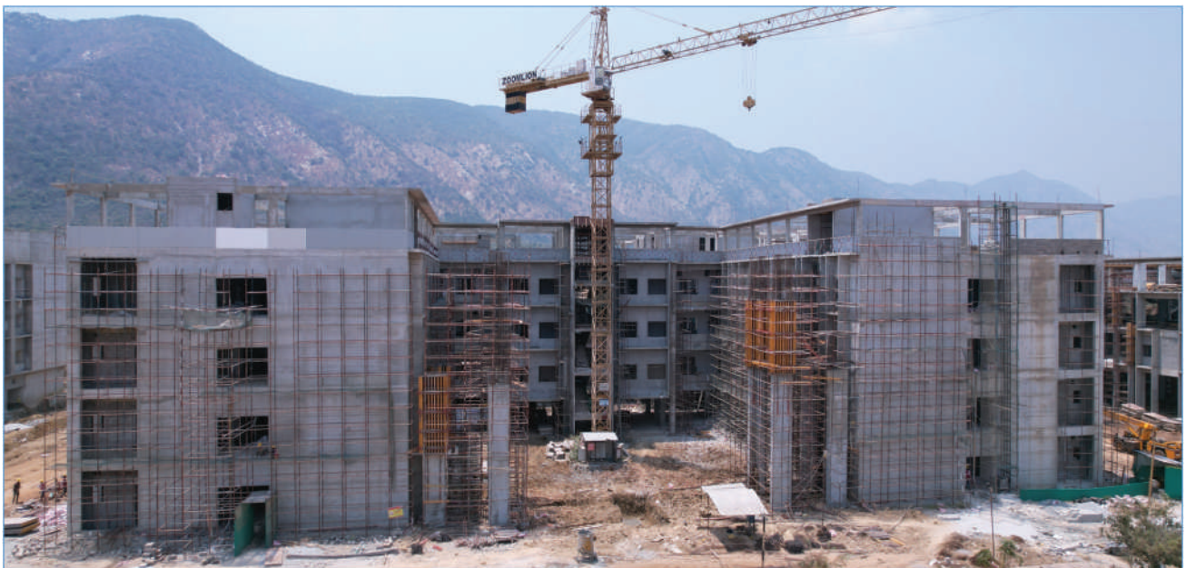
■ विभाग ब्लॉक-1 निर्माण
