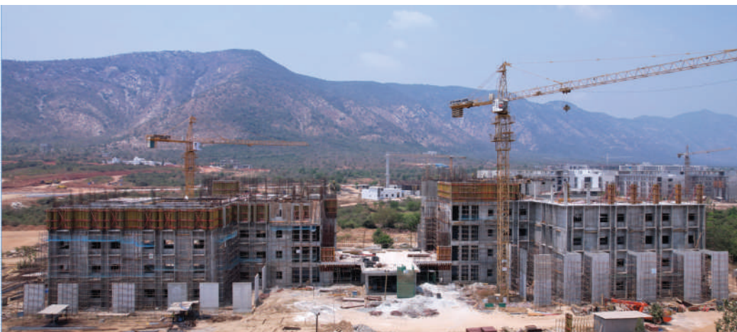
प्रशासनिक ब्लॉक निर्माण
