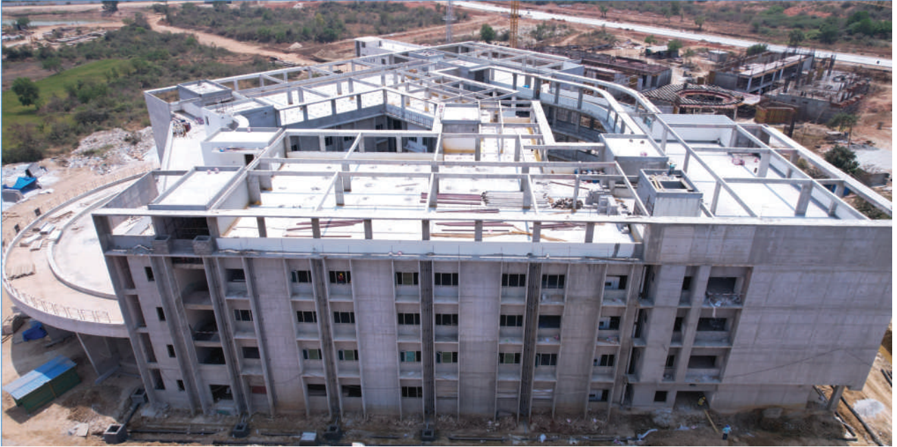
विभाग ब्लॉक-2 निर्माण
